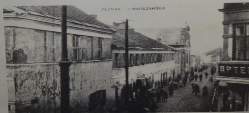
Ulica Warszawska w Płonisku (widok od strony rynku). Z lewej strony widoczny dom, w którym przed wyjazdem z Płoniska w 1906 roku mieszkał Dawid Ben Gurion, oraz synagoga. Fot. Z lat 1914-1918
