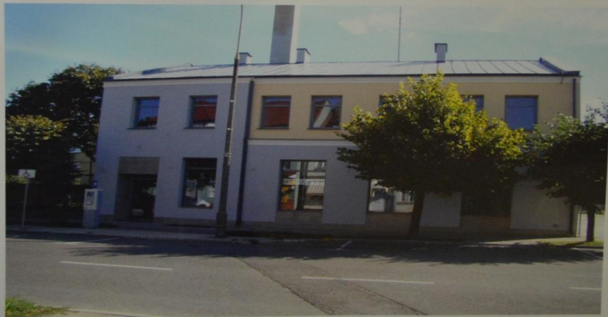
Wybudowany ok. 1900 roku dom przy ulicy Wolności w Płońsku, w którym mieszkał Leon Rutkowski z rodziną, fotografia z 2012 r.
